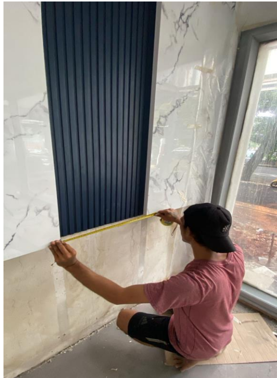
Gambar 1.3 Proses Pengukuran dan Pemasangan
