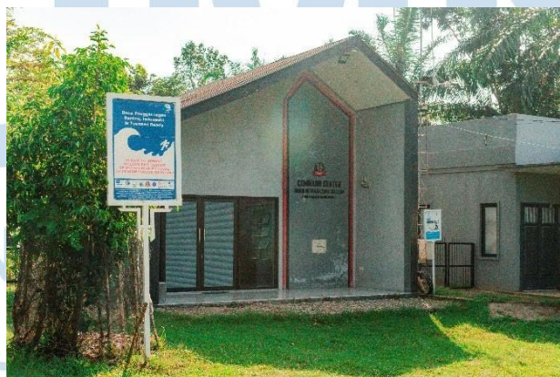
Gambar 1.5 Command Center GMLS Sumber : Dokumentasi pribadi 2025
