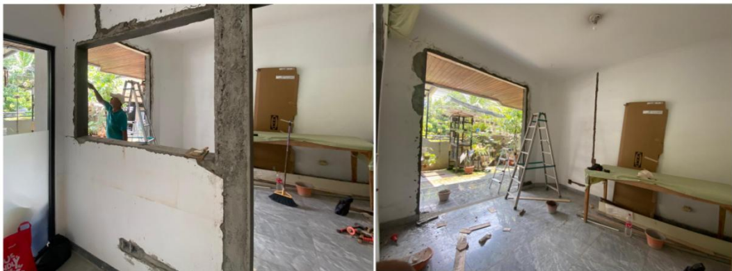
Gambar 2.25 Supervisi Proses Pembobokan
