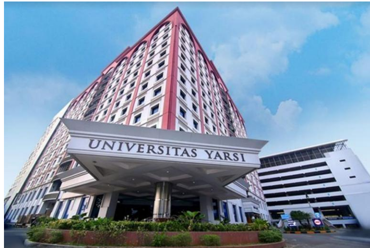
Gambar 1.1 Gedung Universitas YARSI
