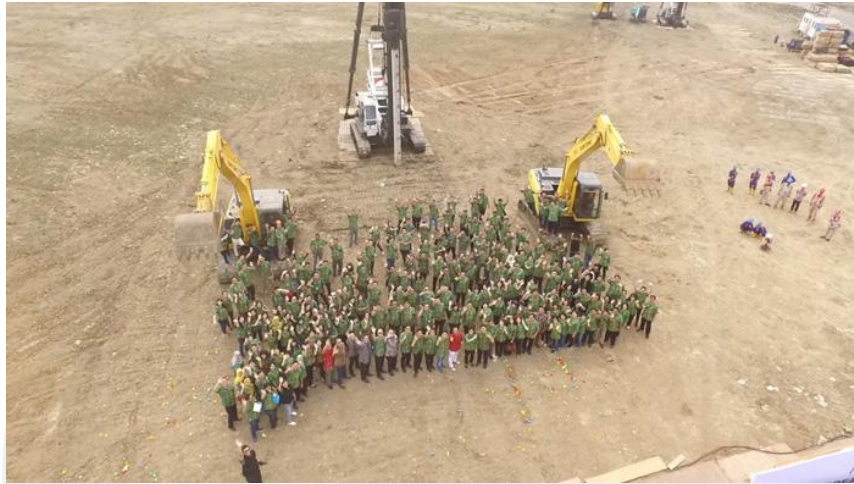
Gambar II.8 Pembangunan Pabrik Baru di Cikarang, Jawa Barat (2017)
