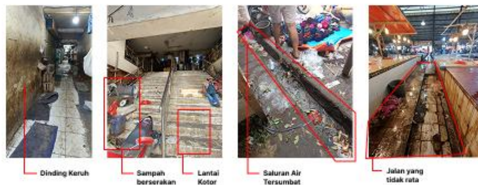
Gambar 2.1 Kondisi Eksisting Pasar Cikupa
