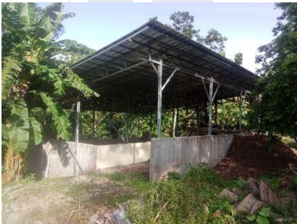
Gambar 1.9 Kondisi Existing Exterior Bangunan Pabrik Penyulingan
