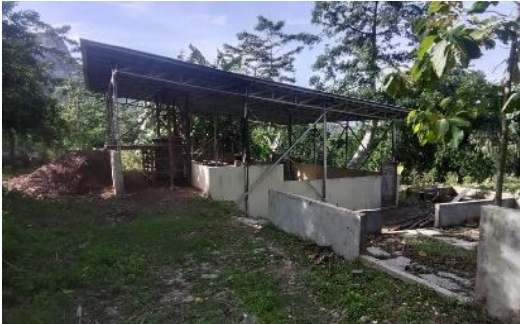
Gambar 1.10 Kondisi Existing Exterior Pabrik Penyulingan dan Area Pengeringan Bahan
