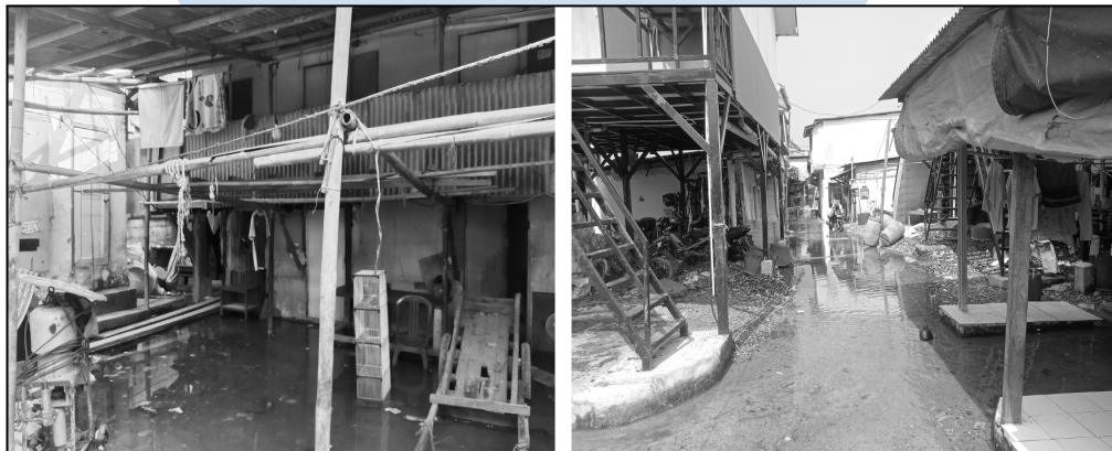
Gambar 1.4 Kondisi saat Banjir Rob pada Kawasan Blok Kerang Ijo
