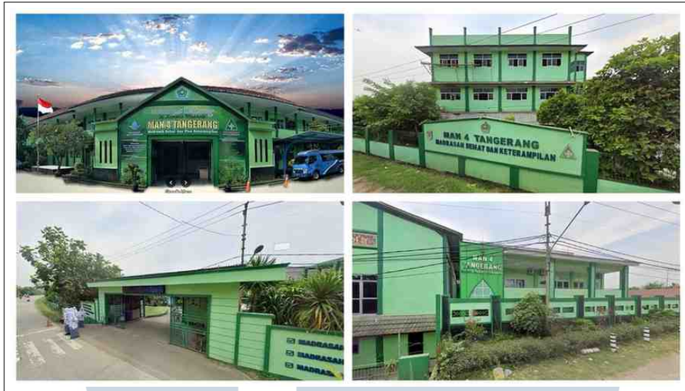
Gambar 2.3. Foto Gedung Sekolah MAN 4 Tangerang
