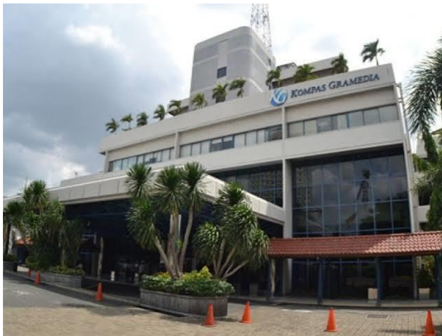
Gambar 2. 2 Gedung Perusahaan Kompas Gramedia
