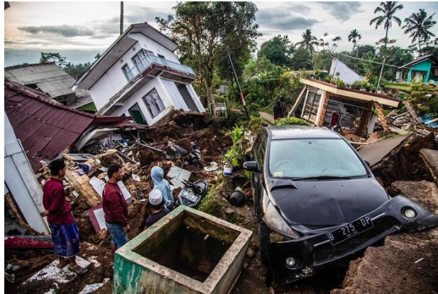
Gambar 1. 5 Kerusakan Gempa Cianjur 2022
