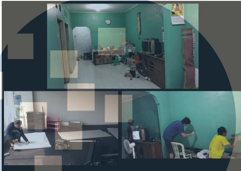
Gambar 3.17. Proses Dismantle (Dokumentasi Pribadi)
