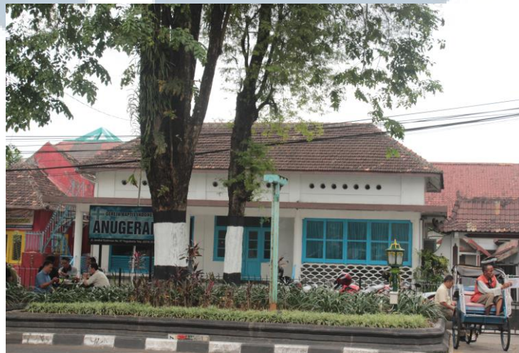
Gambar 3.48. Referensi Foto Bangunan (Dokumen Pribadi)
